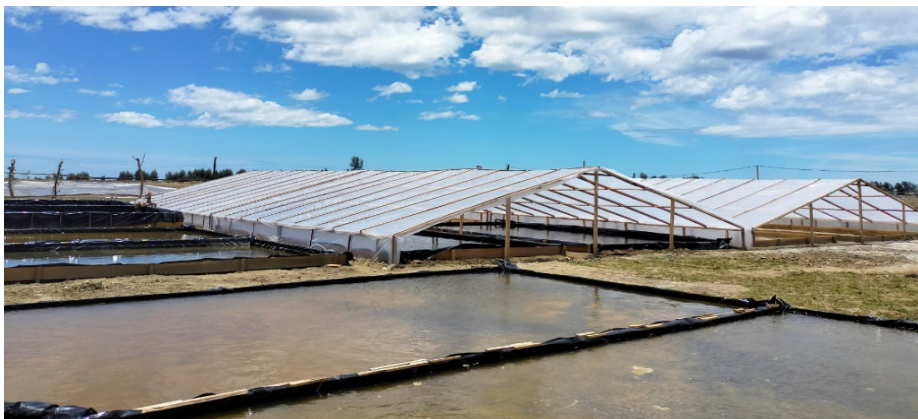
Gambar 3.1 Green House Salt Atau Rumah Tunnel Garam
